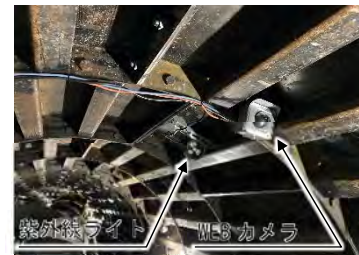
写真-5 機器設置状況（現場②）
