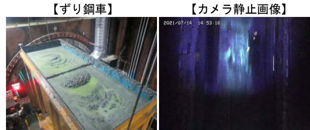
写真-6 目視による染料確認 (現場①)
