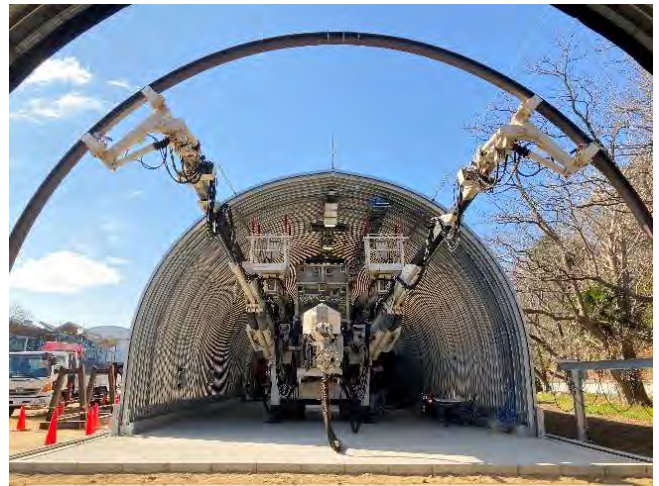
写真-5.1 模擬トンネル内での試験状況
