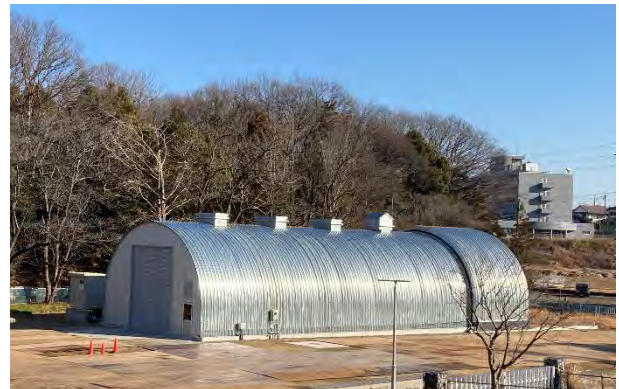
写真-3 ICI キャンプ内 模擬トンネル
