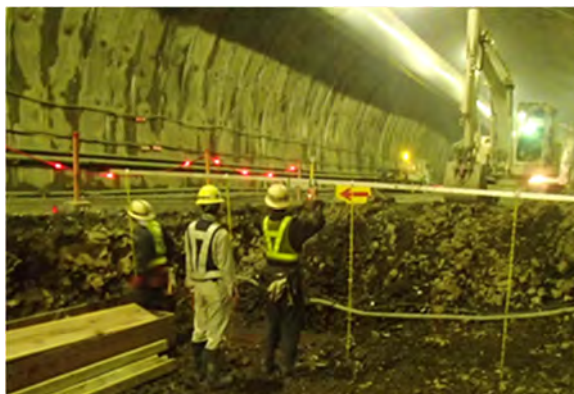
写真-1 従来の掘削高さ確認方法
