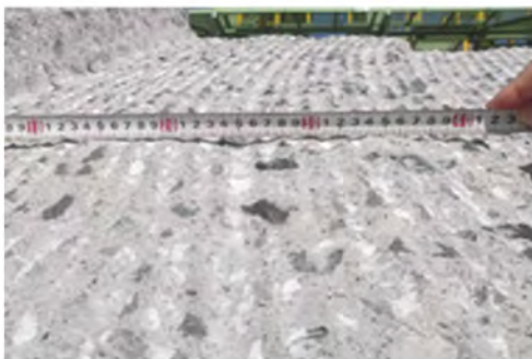
写真-4 コンクリートの切削面
