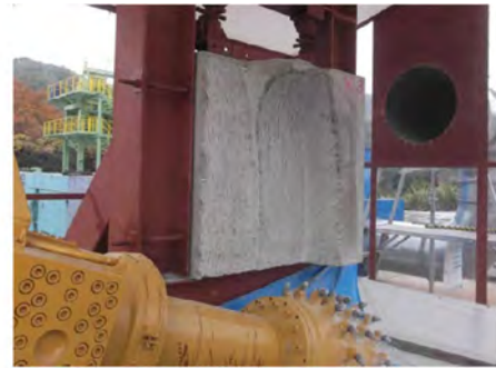
写真-3 切削後コンクリート形状
