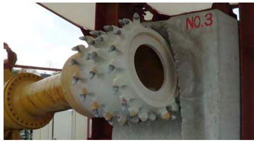
写真-2 切削状況
