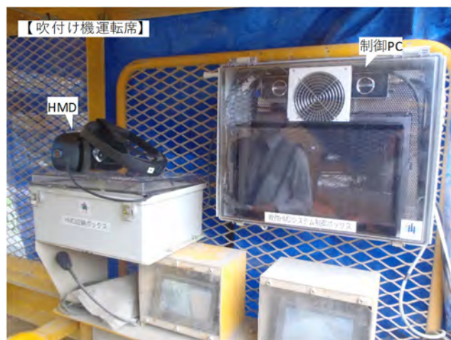
(a) 吹付け機へのシステム設置状況
