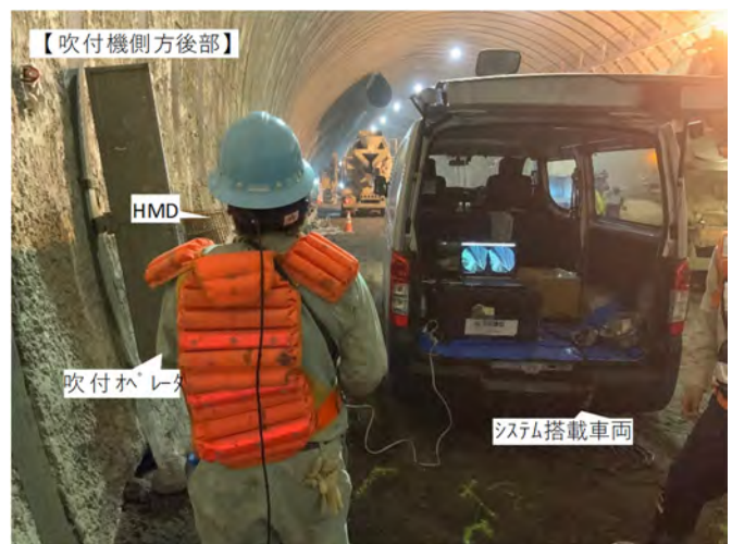
(b) 遠隔吹付け実施状況
