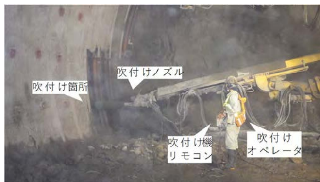
写真-1 従来のトンネル吹付け作業
