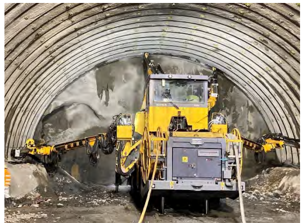
写真-1 コンピュータジャンボによる削孔状況
