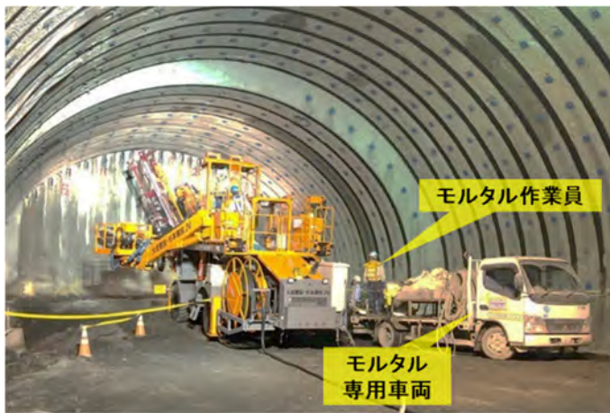
図-3 従来の機械配置 (1号機施工時)
