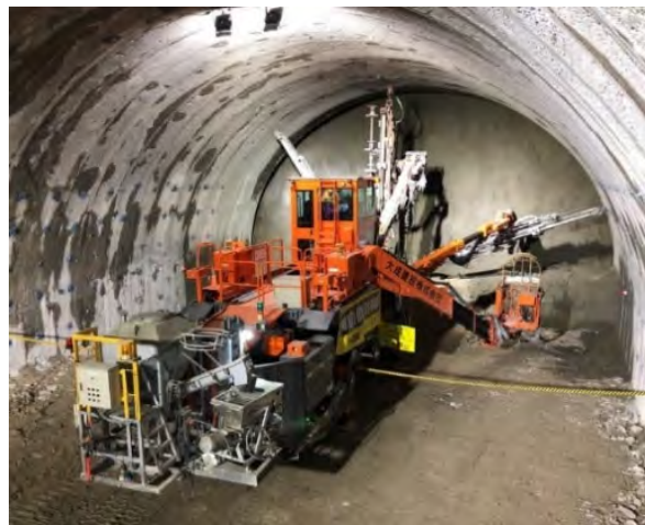
図-10 施工状況全景
