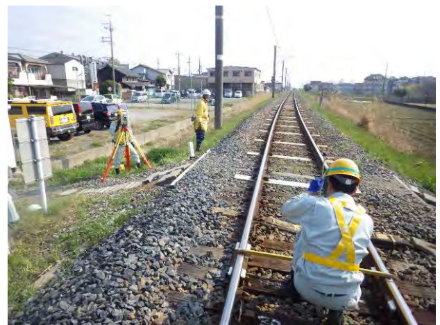
写真-1. 従来測量の様子(軌道中心線測量)
