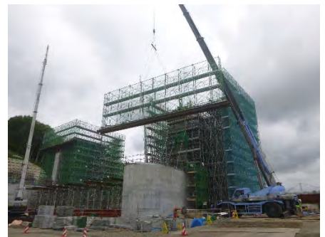
図-1 (c) クレーン作業
