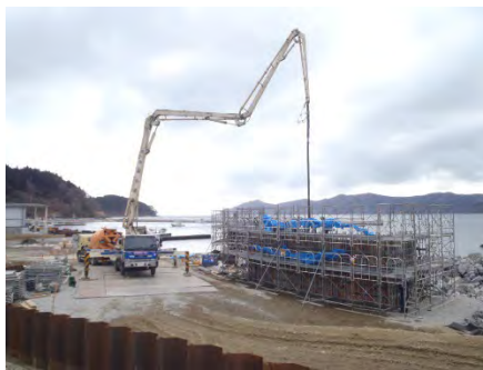
図-1 (b) コンクリート打設作業
