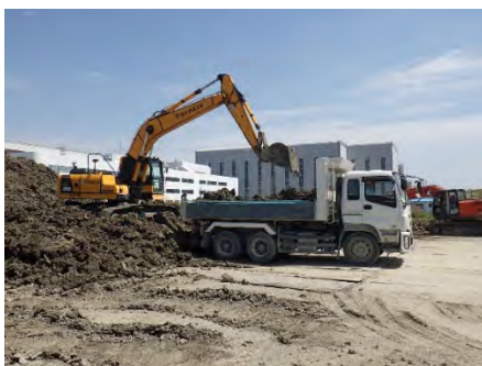
図-1 (a) 土砂運搬作業
