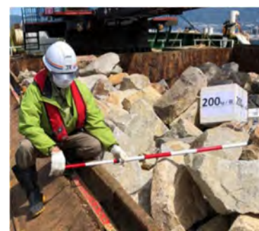
写真-1 検収作業状況
