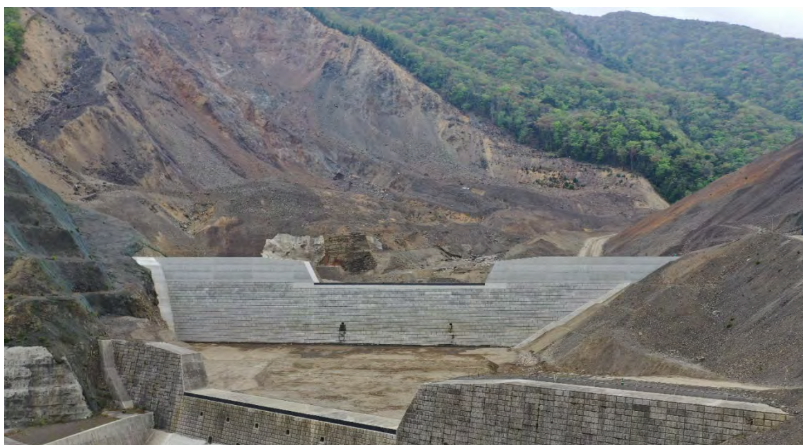
写真-2 3号砂防堰堤完成(2022年4月)
