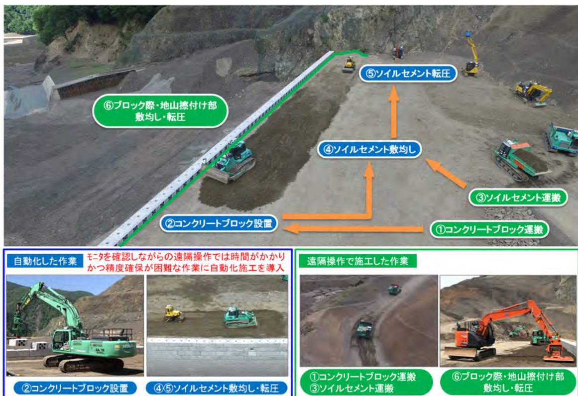
図-6 3号砂防堰堤施工順序
