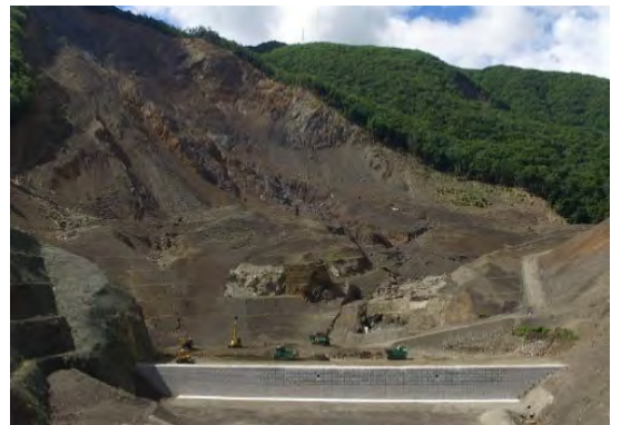
写真-1 施工状況(2021年6月)
