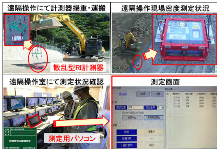
図-15 現場密度測定状況(遠隔操作室)
