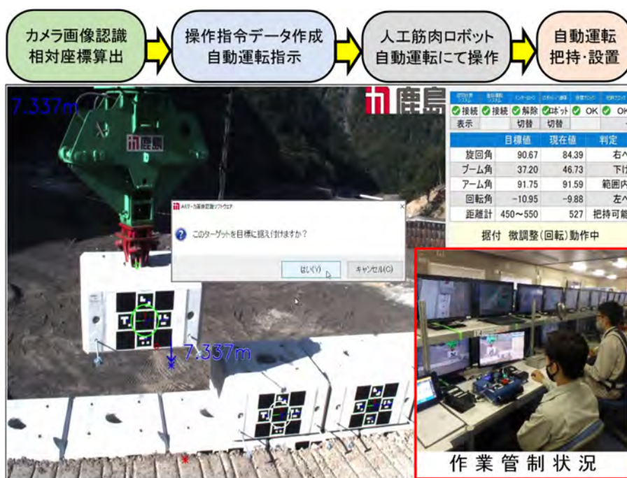
図-17 ブロック設置の自動化施工状況
