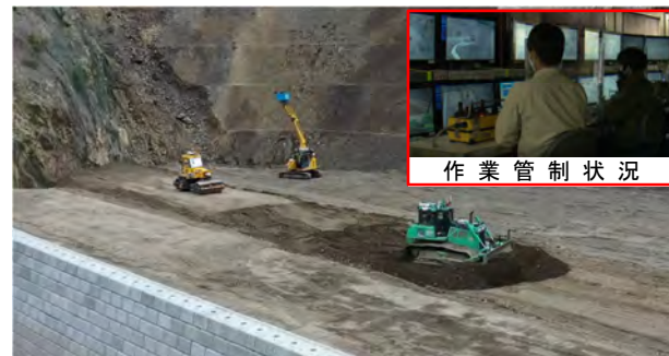
図-19 敷均し・転圧の自動化施工状況
