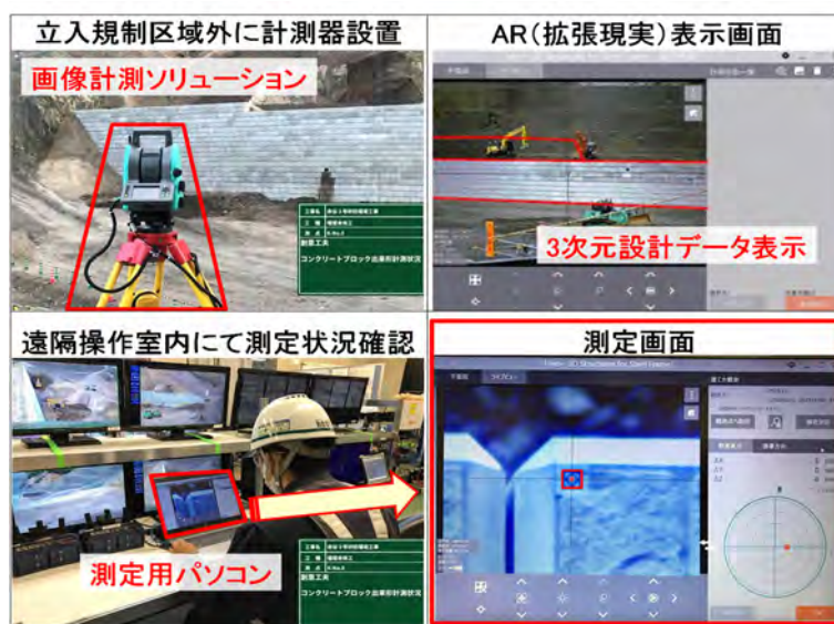
図-16 ブロック出来形測定状況(遠隔操作室)
