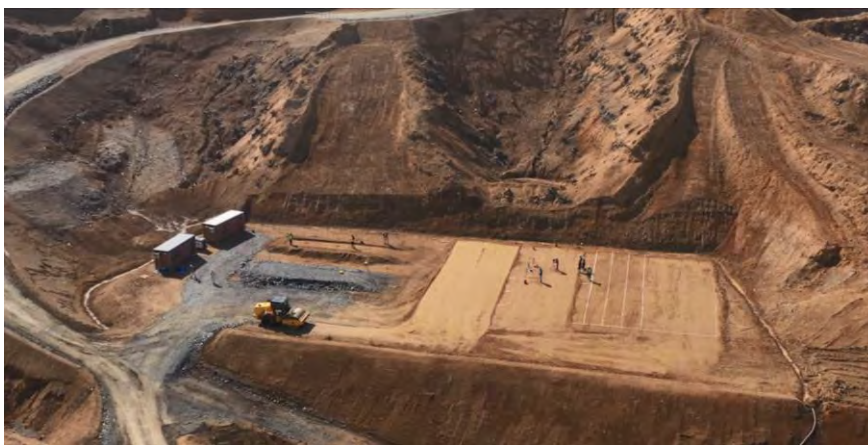
(a) 施工エリア全景
