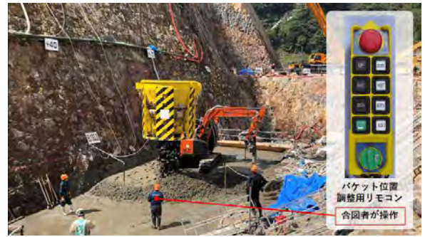
写真-5 自動運転によるコンクリート打設状況
