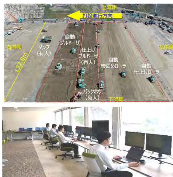
写真-2 自動化施工および管制状況
