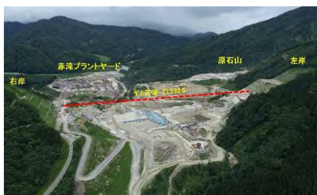
写真-1 施工状況(2022年7月)
