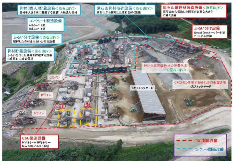
写真-4 赤滝プラント全景
