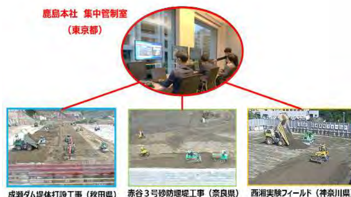
写真-3 遠隔集中管制による施工状況
