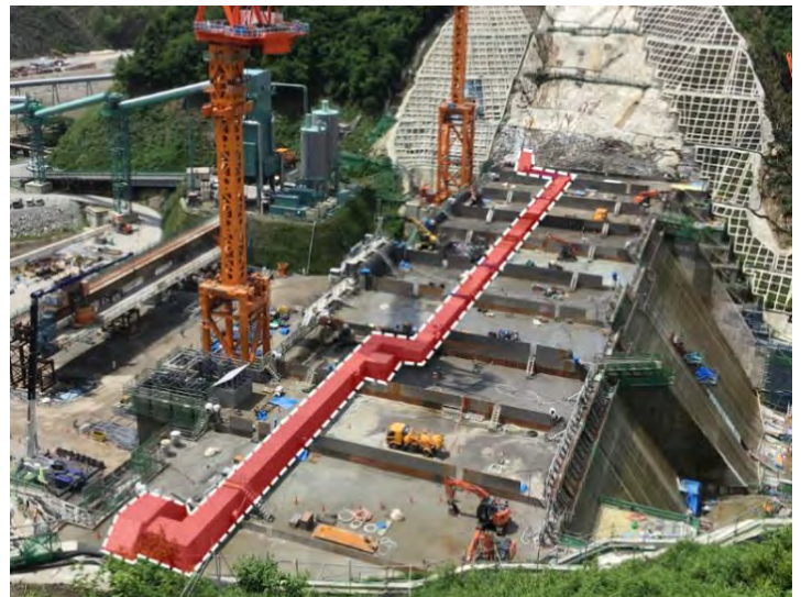
図-9 中段監査廊のフルプレキャスト化状況（破線部）
