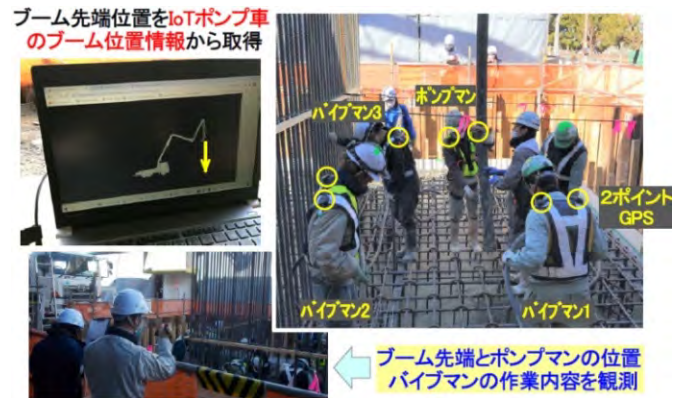
図-10 実施工での作業履歴取得 (塩浜立体での試行)
