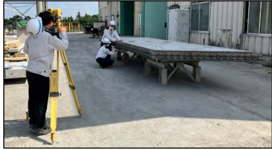
写真-2 製作した床版の計測状況
