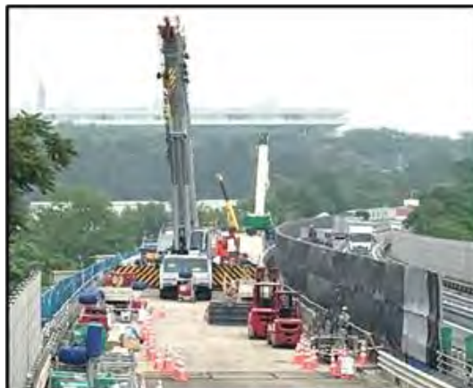
写真-1 床版取替工事の事例
