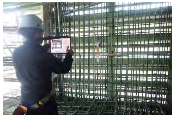
写真-4 ウェブ配筋撮影状況
