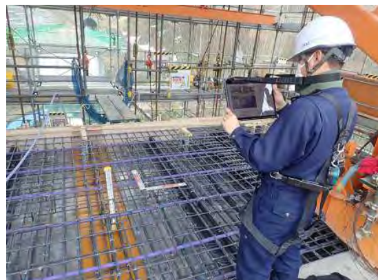
写真-2 本システムの配筋検査状況
