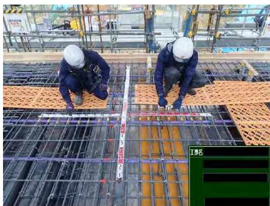
写真-1 従来の配筋検査状況
