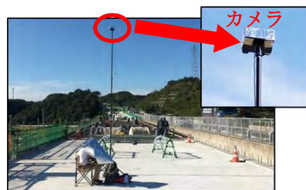
写真-1 機材の配置状況
