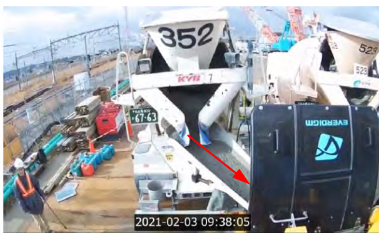
写真-1 流出するコンクリートの検知および運搬車番号、後部ナンバープレートの検知
