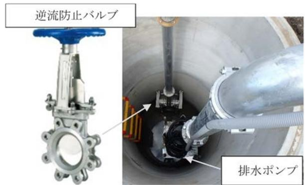
写真-3 ポンプ・バルブ柵内部（雨水）
