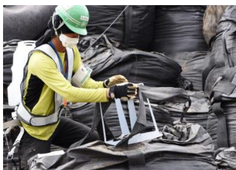
写真-2 フレキシブルコンテナ自立器具の取り付け、及び Siki を用いた荷吊り作業
