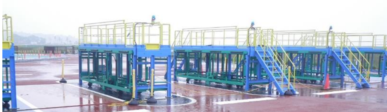
写真-4 全レーンに設置した自動スライド足場
