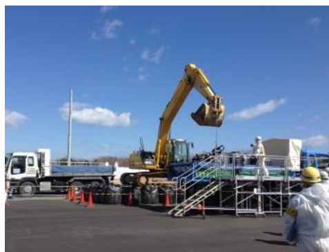
写真-1 一般的な玉掛け・玉外し作業
