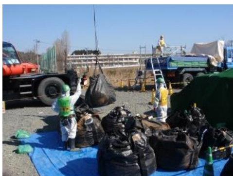
写真-1 一般的な玉掛け・玉外し作業
