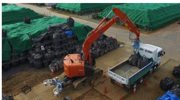
写真-2 フレキシブルコンテナ自立器具の取り付け、及び Siki を用いた荷吊り作業
