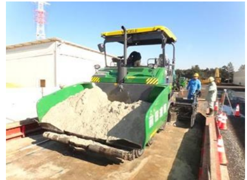
写真-3 アスファルトフィニッシャー
