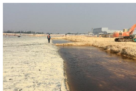
写真-5 端部処理部水張り状況
