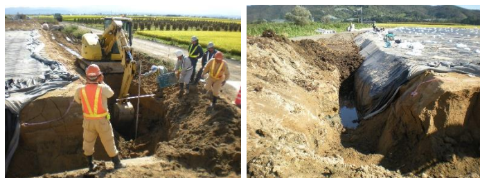
写真-2 気密シート端部処理事例（日本）
