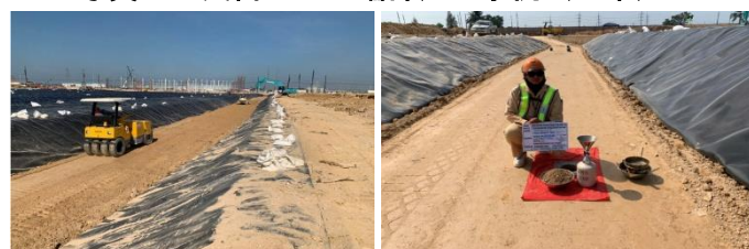
写真-3 気密シート端部処理（当地）
