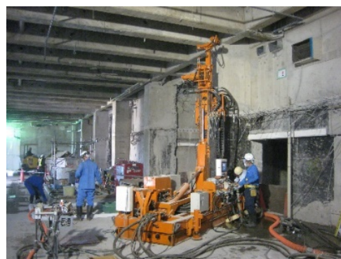
図-8 建物内での施工事例
