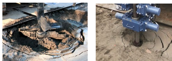
(a) 固定式攪拌翼 (b) 拡翼型攪拌翼
