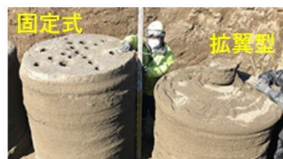
図-11 事後掘削調査による改良体の状況
