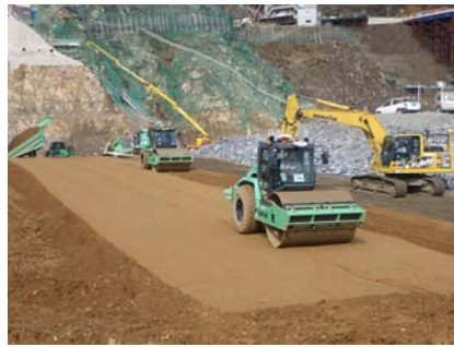
図-7 コアの転圧状況
