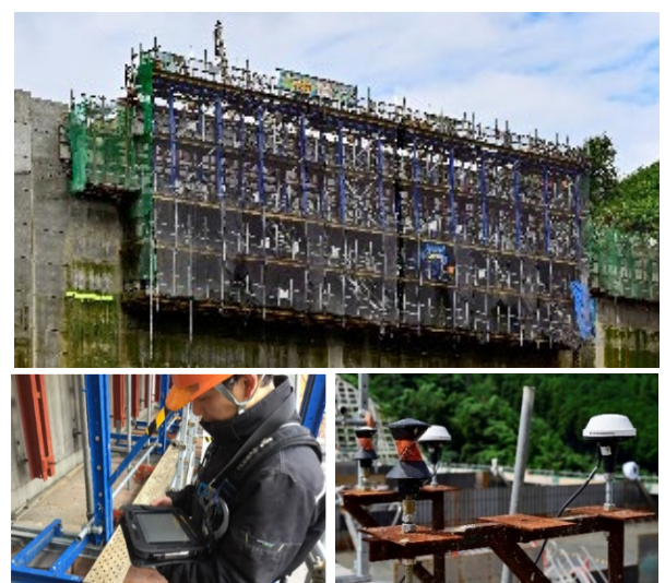
図-3 ダム型枠自動スライドシステム
