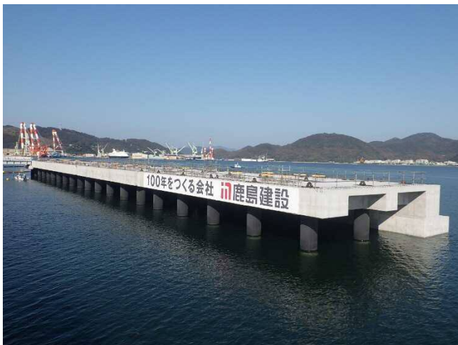
写真-11 プレキャスト栈橋一括架設完了
