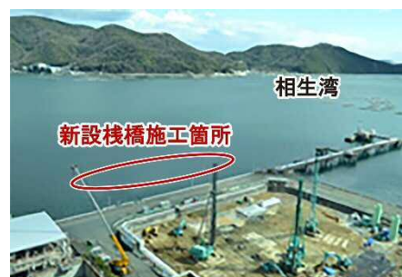
写真-1 施工箇所
