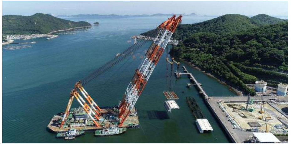
写真－５ プレキャスト栈橋降下作業
