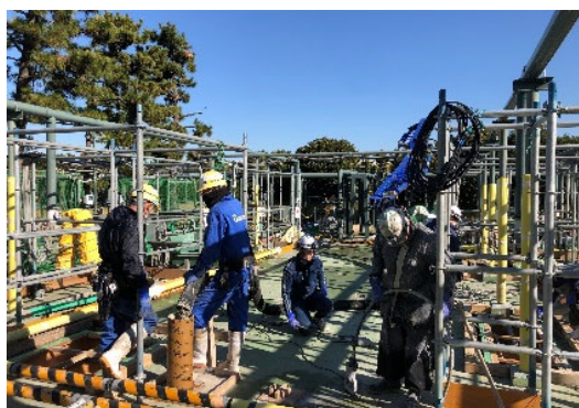
写真-5 スラブ打設状況
