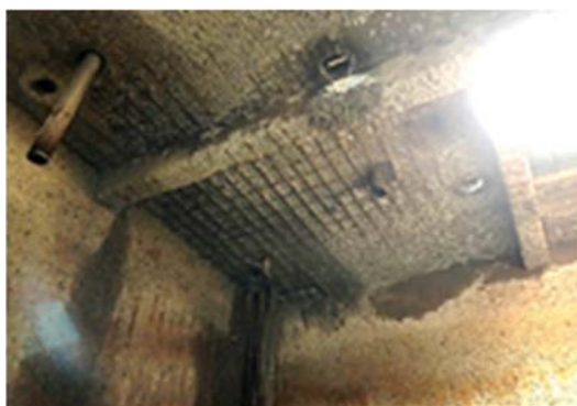
写真-2 補修前(気層部)
