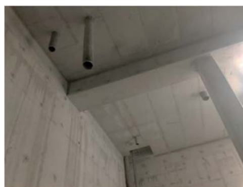
写真-6 補修完了
