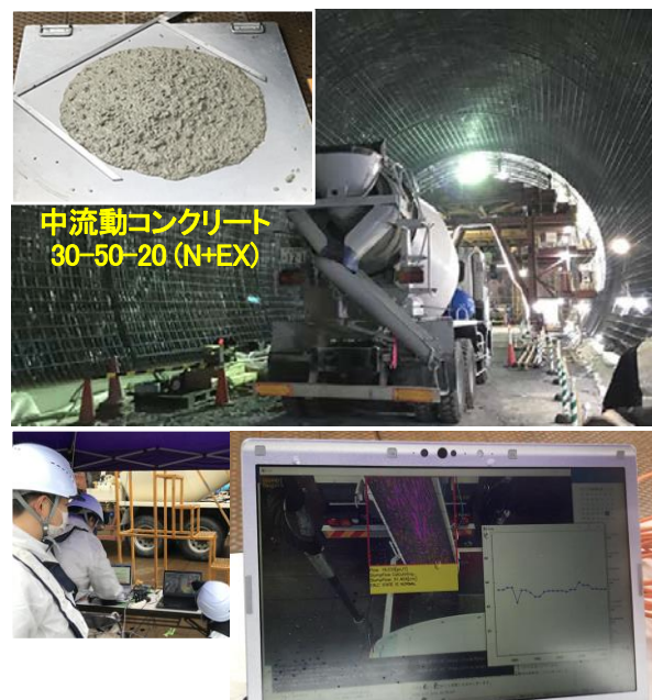
図-13 トンネル構内状況とスランプフロー推定
