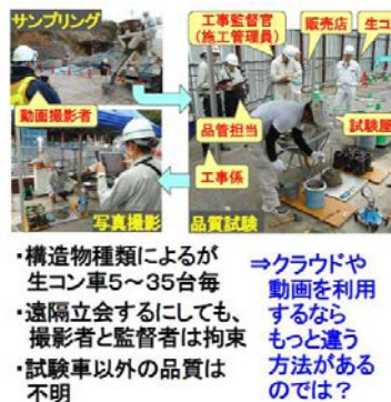
図-2 コンクリート現場受入れに全数検査を導入
