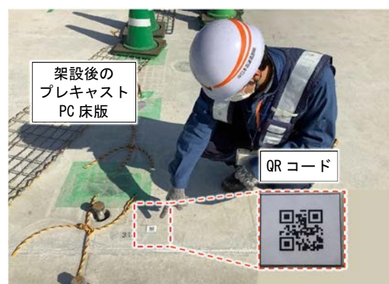
写真-3 架設後の貼り付け状況(現場)
