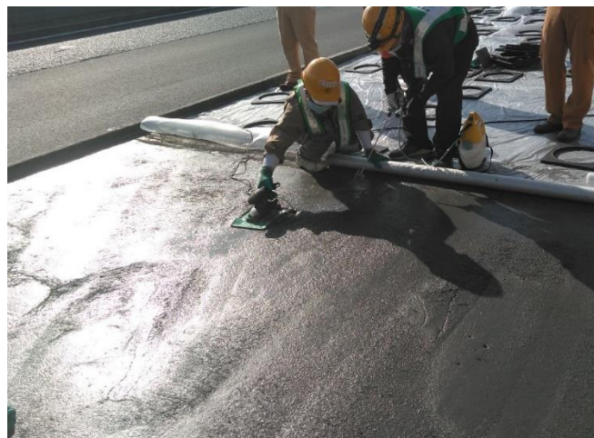
写真-9 電動振動コテ使用状況
