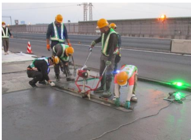
写真-8 大型エンジンスクリード使用
