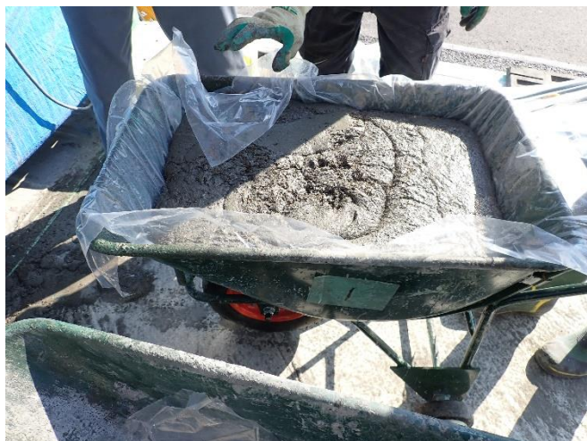
写真-6 手押し車運搬
