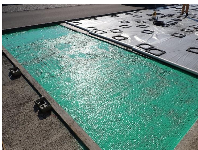
写真-10 接着剤塗布およびポリシート養生実施
