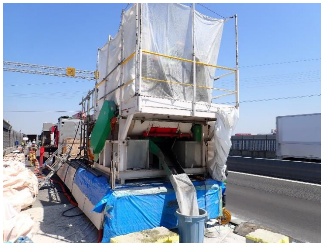
写真-5 車上プラント配置状況
