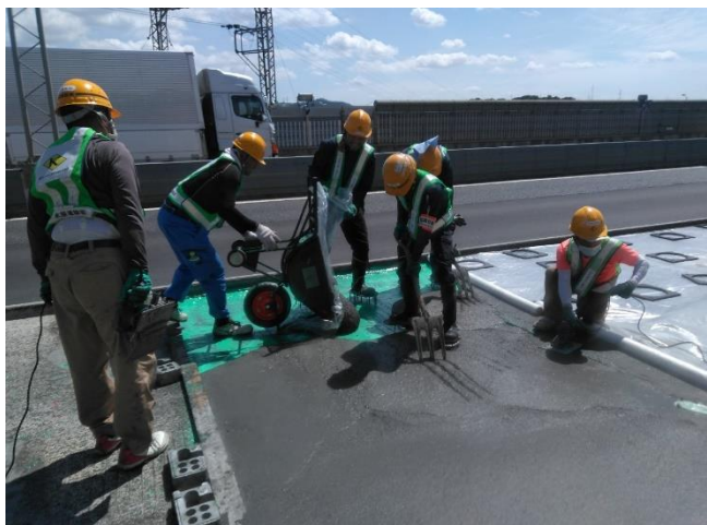
写真-7 打ち込み状況
