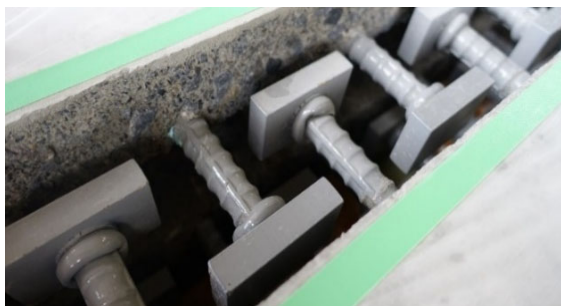
写真-1 PCa床版の継手構造
