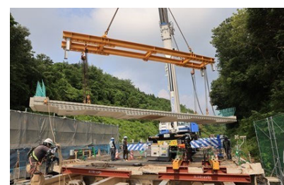
写真-5 PCa 床版の架設状況
