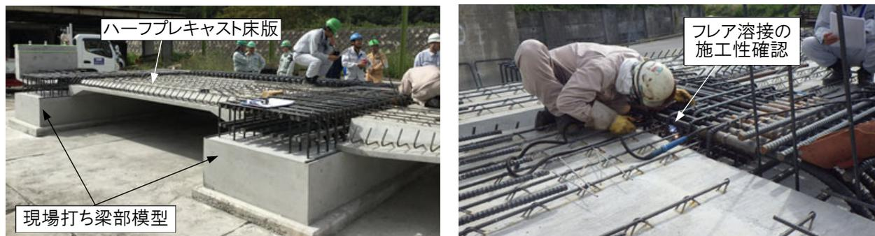
図-5 ハーフプレキャスト床版架設の実物大試験
