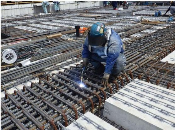
図-12 梁・HPCa 床版接続部のフレア溶接状況
