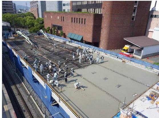
図-13 床版コンクリート打設状況
