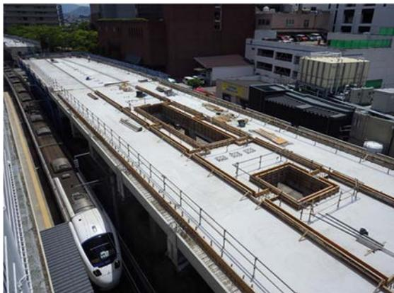
図-14 床版コンクリート打設完了
