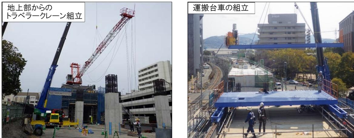
図-10 トラベラークレーン・運搬台車の組立
