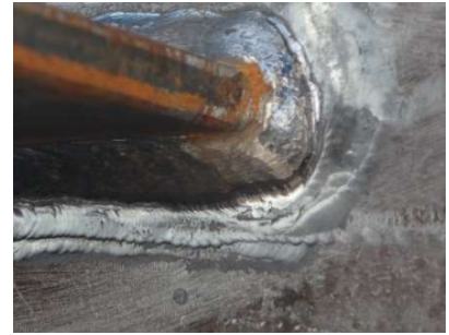
(a) 平板を用いた ICR 処理 (b) 面外ガセットを用いた ICR 処理 (c) ICR 処理部の拡大写真
