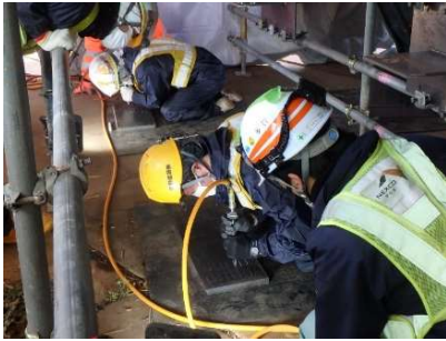
(a) 平板を用いた ICR 処理 (b) 面外ガセットを用いた ICR 処理 (c) ICR 処理部の拡大写真
