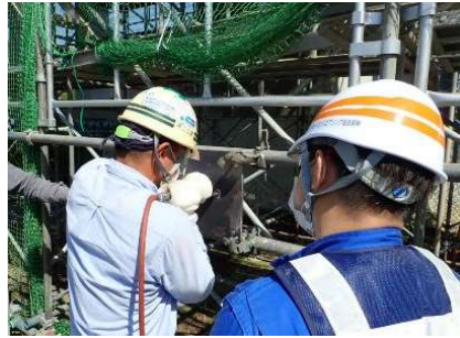
(a) 平板を用いた ICR 処理 (b) 面外ガセットを用いた ICR 処理 (c) ICR 処理部の拡大写真
