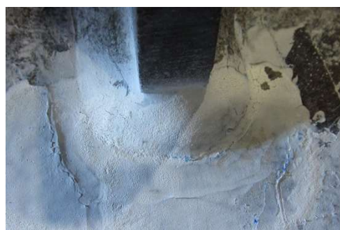
(b) 浸透探傷試験(PT)の状況
