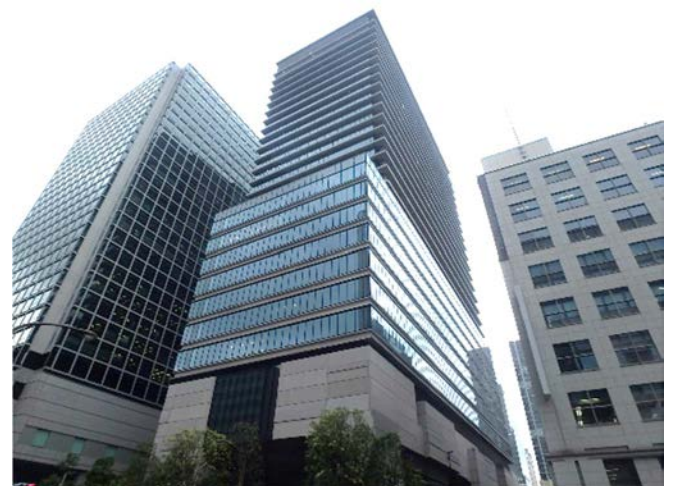
写真-1 新設ビル遠景
