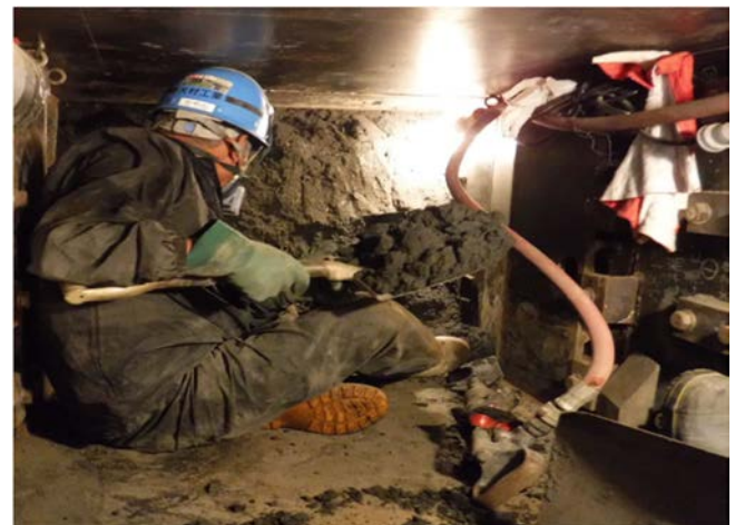
写真-3 切羽の人力掘削
