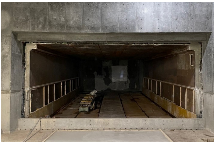
写真-5 地下連絡通路躯体構築完了
