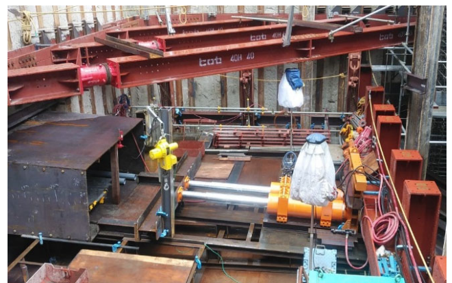
写真-2 推進施工ヤード遠景
