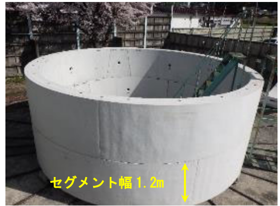
写真-5 水平仮組状況
