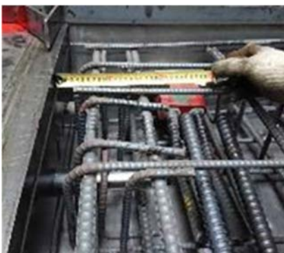
a) 配筋検査
