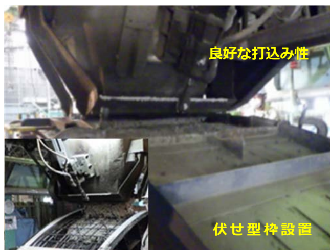
写真-1 セグメント型枠への打込み状況
