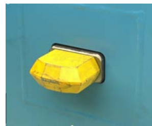
写真-9 新ビット交換完了
