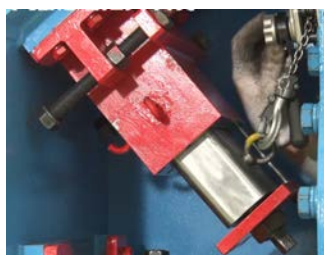
写真-10 旧ビット引込み
