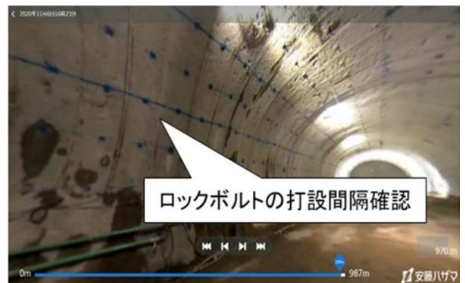
図-7 ロックボルト打設間隔の確認
