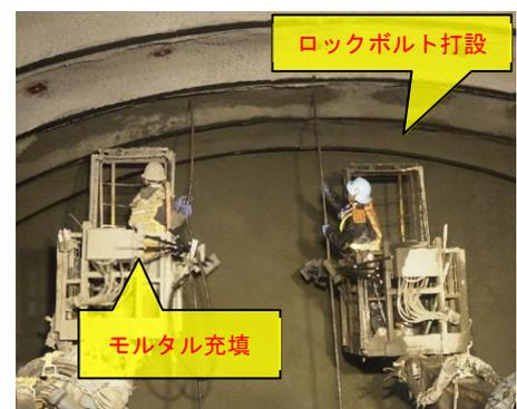
図-1 人力によるロックボルト施工状況
