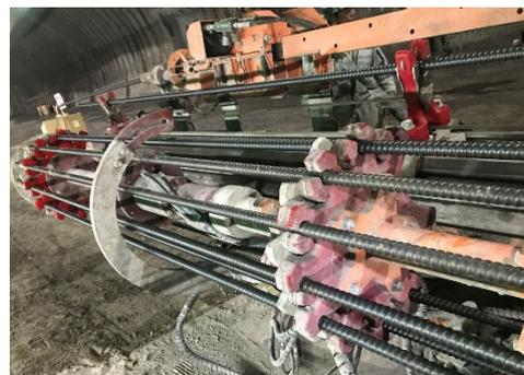
図-16 マガジンへのロックボルト装填状況
