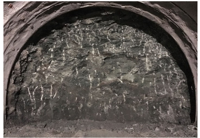
(No.721, STA.46+79.1) 図-3 実証試験区間の切羽写真 (No. 721, STA. 46+79. 1)
