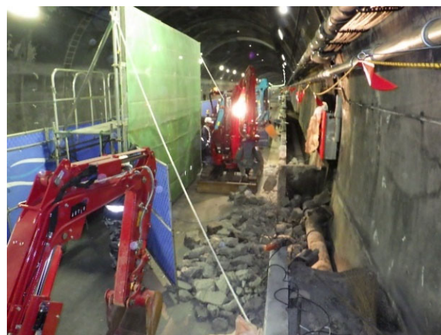
写真-7 移動式飛散防止柵
