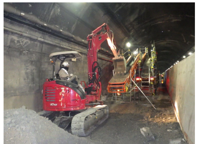
写真-3 ベルトコンベア設備積込状況
