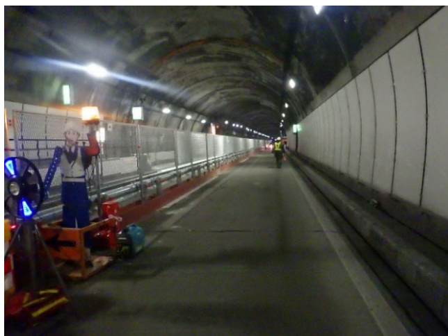
写真-4 仮設ガードレール
