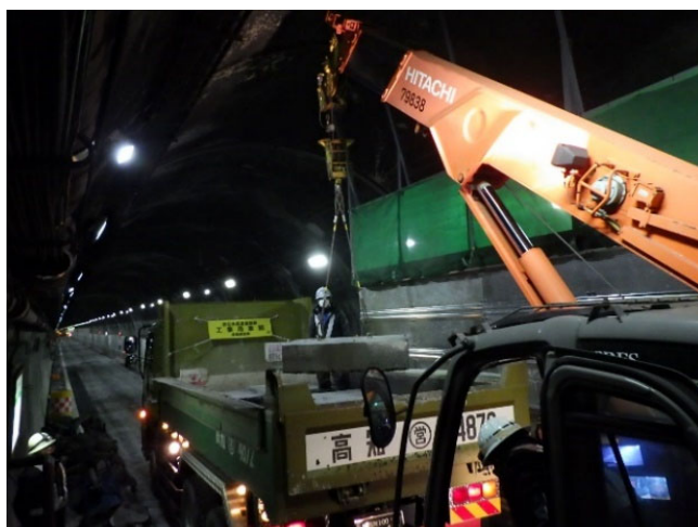
写真-6 コンクリートブロック積込状況
