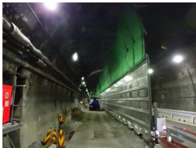
写真-5 飛散防止柵
