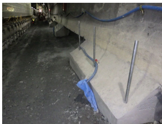
写真-1 足付けインバートコンクリート
