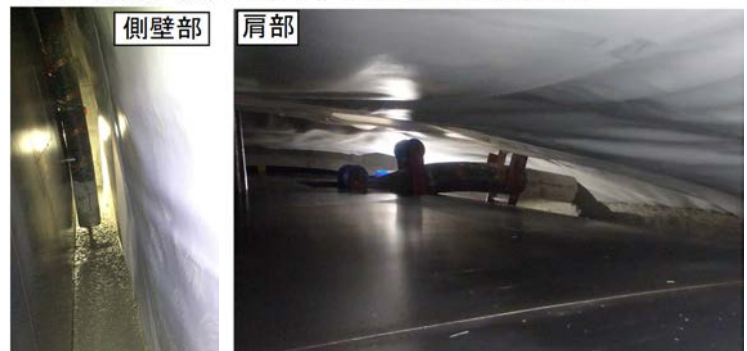
写真-7 本システムによる打設状況
