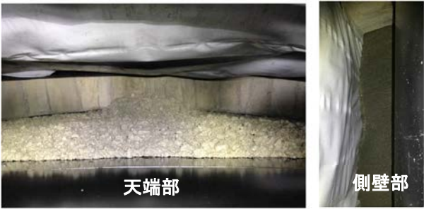
写真-4 高流動コンクリートの流動状況
