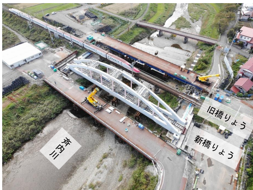
図-6 斉内川橋りょう(施工時)
