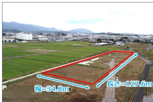
写真-1 盛土前の状況
