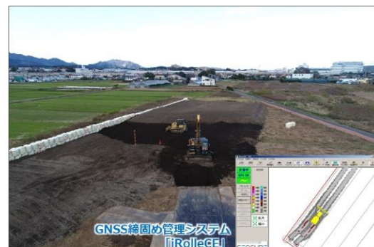
写真-2 盛土の施工状況
