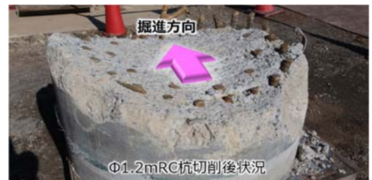
写真-5 杭切削後の状況
