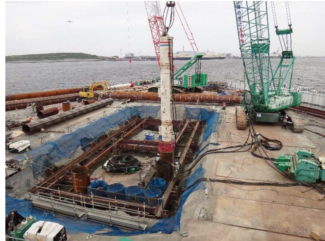
写真-14 上杭打設（油圧ハンマ）
