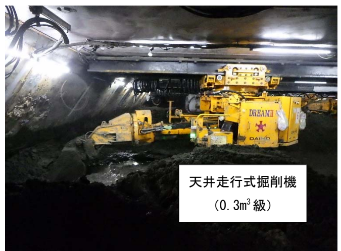
写真-4 沈下掘削（無人掘削）
