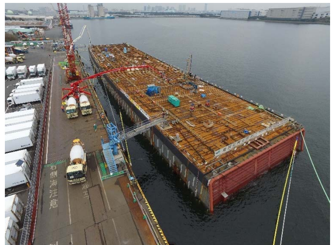
写真-18 高流動コンクリート打設（京葉食品）
