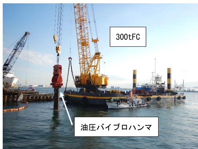
写真-15 既設鋼管矢板引抜工状況（300t 吊起重機船）
