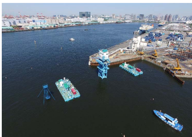
写真-27 沈埋函沈設完了（現地）
