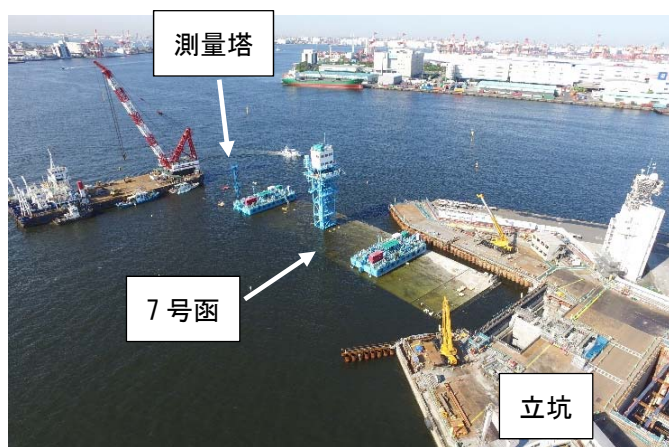
写真-19 沈埋函（7号函）沈設状況
