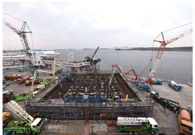
写真-2 コンクリート打設状況
