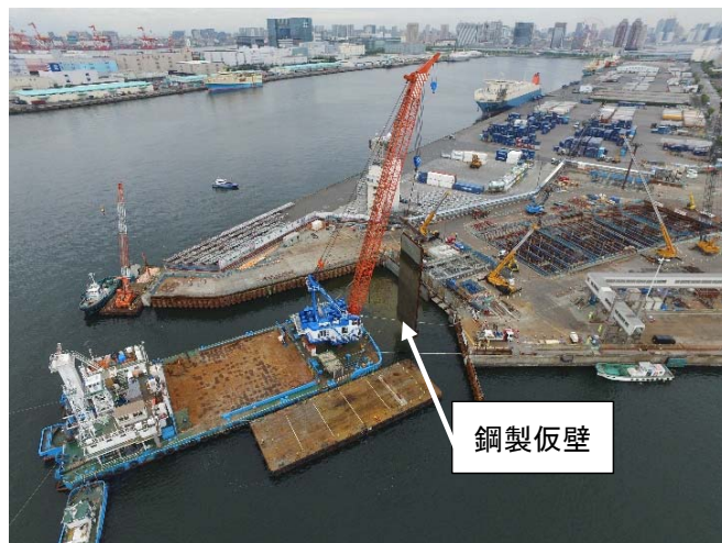
写真-8 鋼製仮壁撤去状況（400t 吊起重機船）
