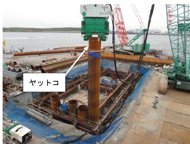
写真-13 下杭打設（油圧式パイプロハンマ）
