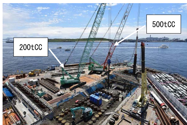
写真-11 鋼管矢板打設状況
