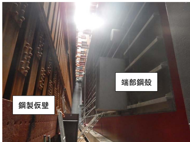
写真-7 端面調整工状況
