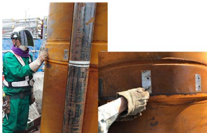
写真-12 鋼管矢板機械式継手（ラクニカンジョイント）
