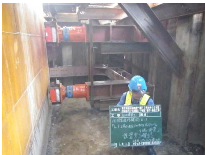
写真-3 ガイドローラによる変位抑制
