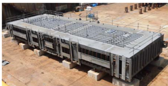
写真-5 端部鋼殻製作状況（日立造船(株)堺工場）
