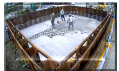
図1 掘削地盤造成状況
