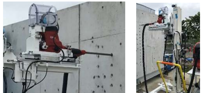
写真-3 自動削孔の状況
