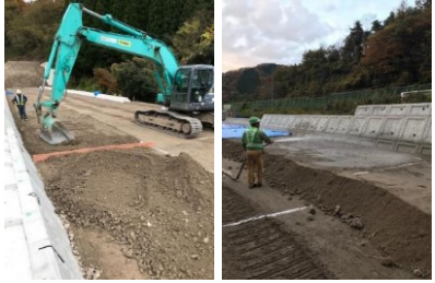
① 試験盛土B 造成状況 ② 湿潤ヤード加水状況
