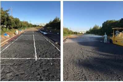
① 試験盛土A 全景 ② 湿潤ヤード加水状況
